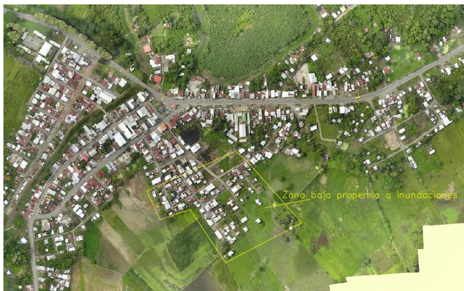
El nivel de esta zona es muy bajo y en época invernal se inundan
